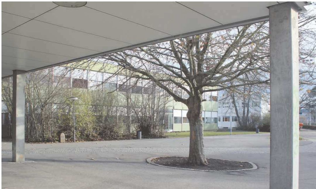
Das Gebäude des Schulverbunds am Deutenberg ist völlig marode. Es gibt jetzt Hoffnung, dass die Sanierung in Angriff genommen wird, wenn das gegenüberliegende Gymnasium modernisiert ist. Foto: Berthold Merkle
